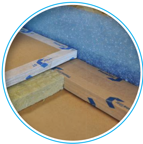
Akusztkai mérőhelyiség PhoneStar Schalli szalaggal a padlón – teljes kerület mentén
