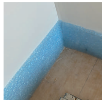
A peremszigetelő csík illesztése a sarokban
