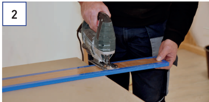
VÁGJA MÉRETRE A REZGÉSCSILLAPÍTÓ ÉS MEGKERÜLŐ-HANG-GÁTLÓ CSÍKOT
